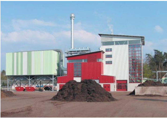
Die neue Biotherm-Anlage mit 5 MW
